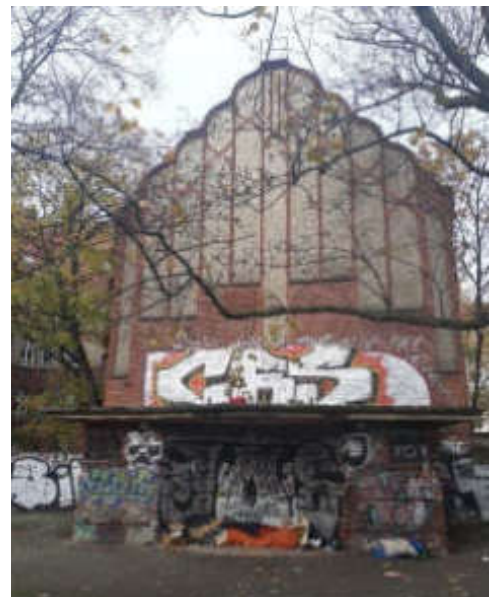
Abb. 61: Toilettenhaus im Ottopark
