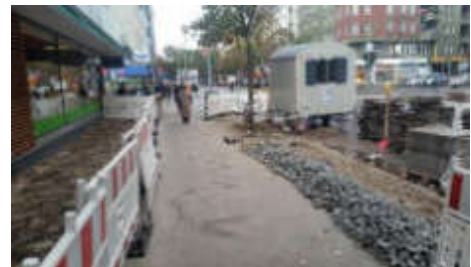
Abb. 76: Baustelle zu den Seitenbereichen in der Turmstraße
