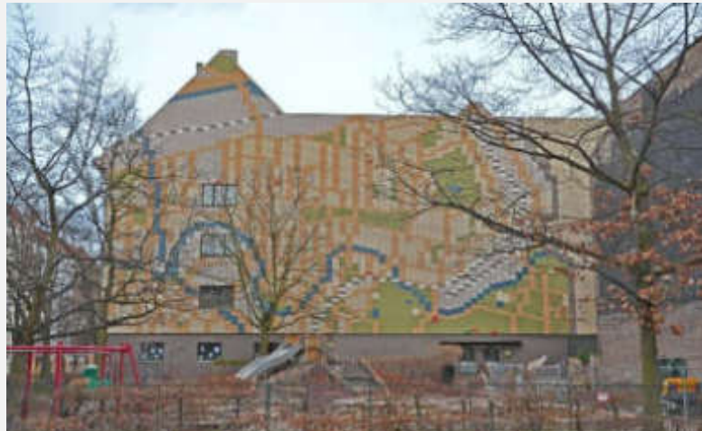
Abb. 19: An das Gebäude der Carl-Bolle-Grundschule angrenzender Spielplatz
