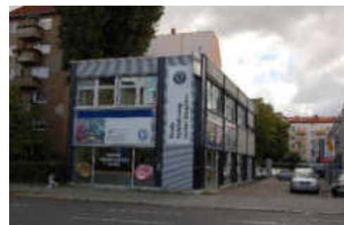
Abb. 63: ehem. Autohaus Beusselstraße 32-33
