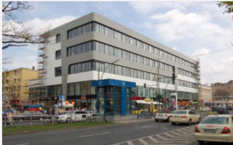
Abb. 17: Sanierung auf dem ehemaligen Hertie-Standort
