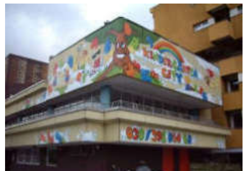
Abb. 53: Kita in der Straße Alt-Moabit 117 A
