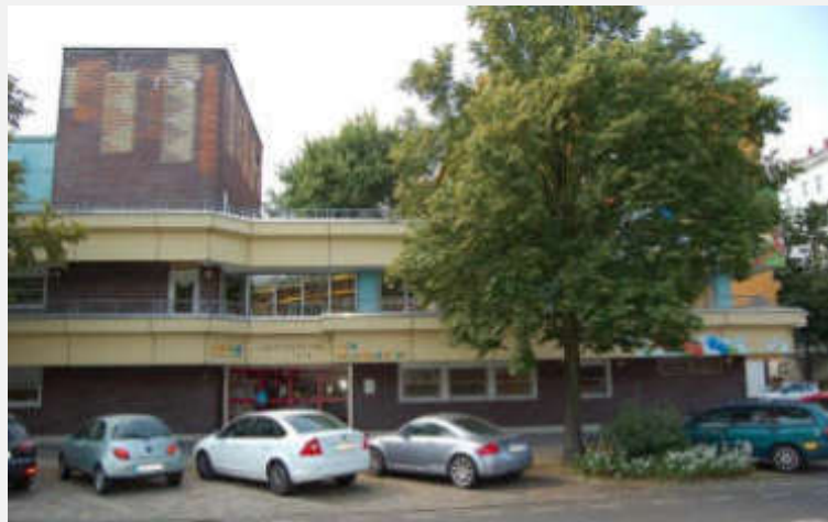
Abb. 25: Fassade des Gebäudes der Kita Alt-Moabit 117a
