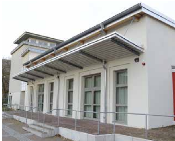
Bertolt-Brecht-Oberschule Neubau Aula
