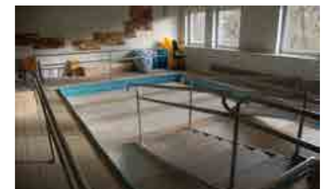
Schwimmbad Kita Hoppetosse Bestand
