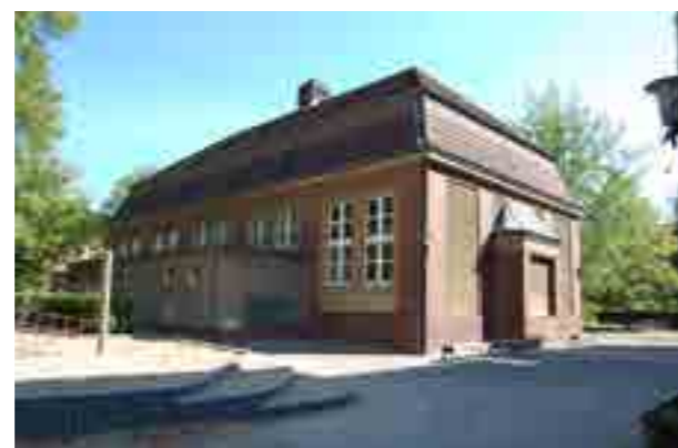
Bestandsgebäude alte Turnhalle
