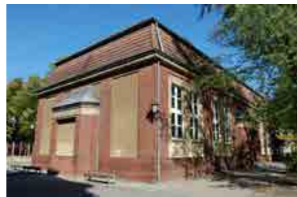
Bestandsgebäude alte Turnhalle
