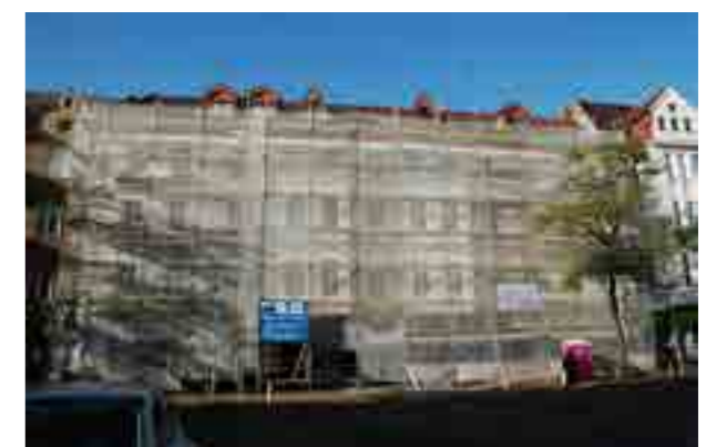
Baustelle in der Pichelsdorfer Straße
