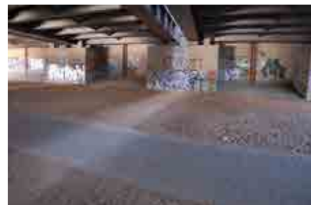
Gehweg unter DB-Unterführung
