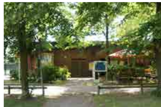
Bestandsgebäude Sportanlage Ziegelhof Vorderansicht
