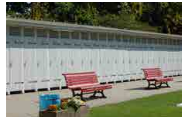
Umkleiden FreizeitSportanlage Südpark
