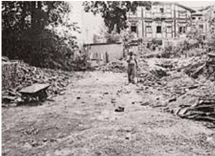
Die Reste ein Schutthaufen – die Keller sind noch da.
