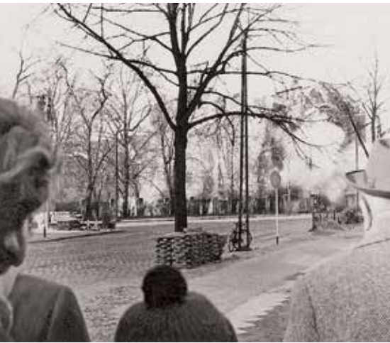
Die Sprengung des Hauses Wilhelmstraße 3
